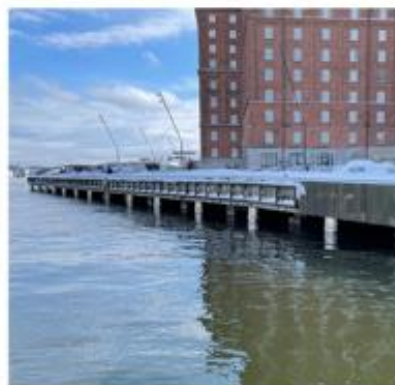
Kaj på pelare vid Saltsjöqvarn med kajskoning av ett raster i trä.
