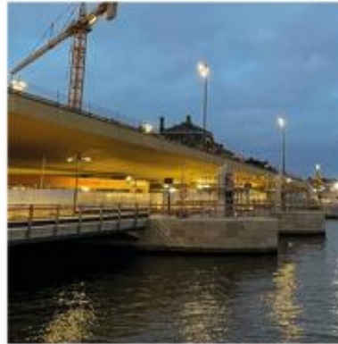
Nya Slussen. En variation av platsgjutna och prefabricerade konstruktioner. Klädda i granit.
