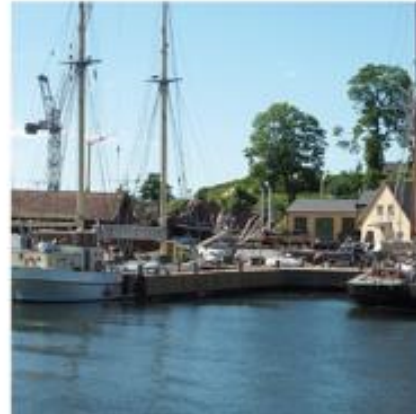
Brygga på träpålar. Befintlig brygga på Beckholmens östra sida.
